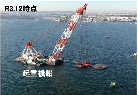
● 岸壁本体 (鋼板セル) の据付状況
