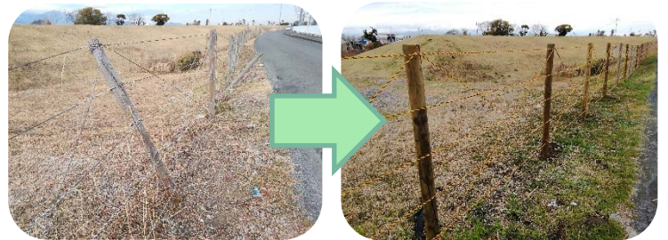
木杭ロープ柵の補修前後
