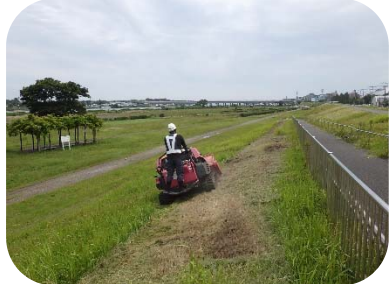
堤防の除草作業
