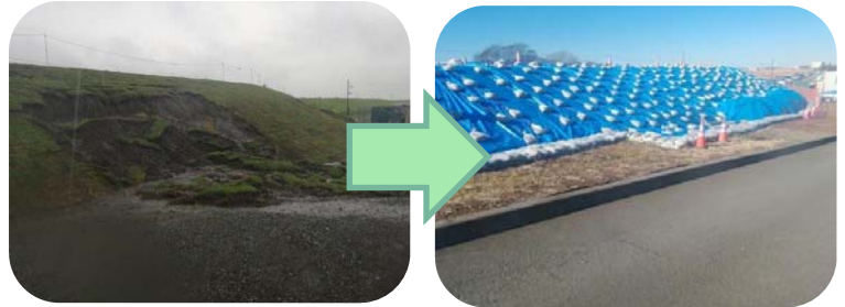
堤防の法崩れの補修前後
