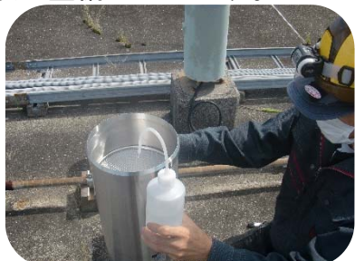
水文・水理観測機器の点検補修
