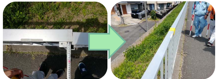
手すりの補修前後
