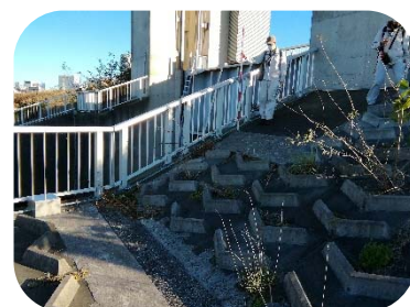
鶴見川遊水地排水門の点検
