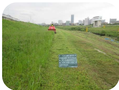
堤防の除草作業
