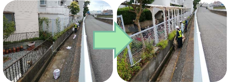
堤防の堤脚側溝の清掃前後
