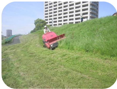
堤防の除草作業
