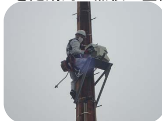
監視カメラ（CCTV）
