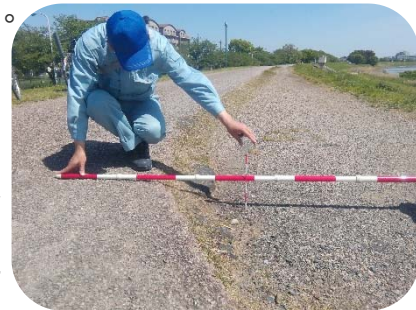
堤防の段差を確認
