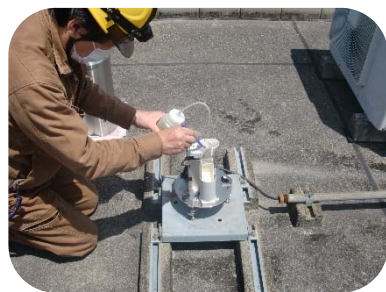
水文・水理観測機器の点検補修
