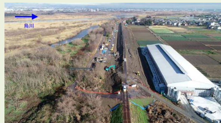
八町河原地先 堤防補修工事
