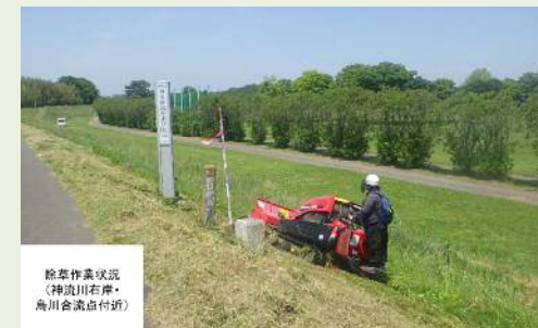
堤防除草の様子
