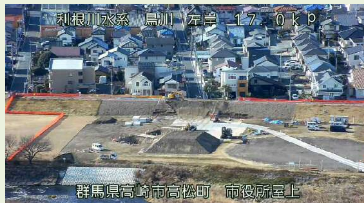
石原地先 石原第2樋管撤去工事
