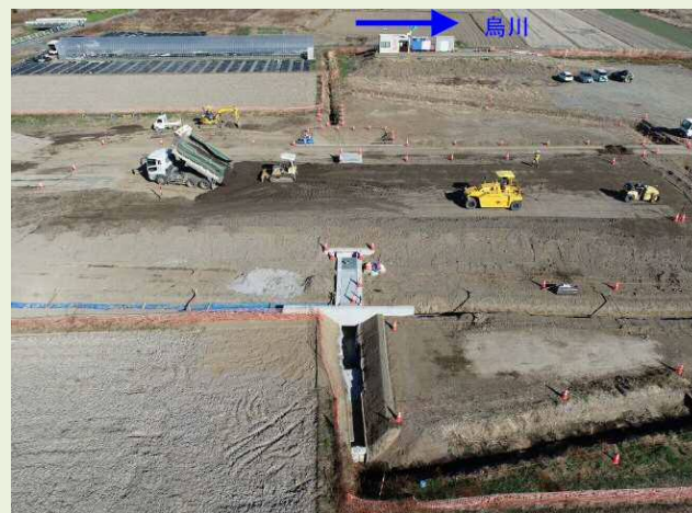
根小屋地先 樋管新設工事
