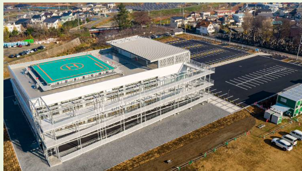
最大2,000人を収容できる防災機能を備えた体育館
