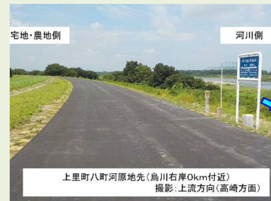
堤防補修工事後(R4.7末完成状況)
