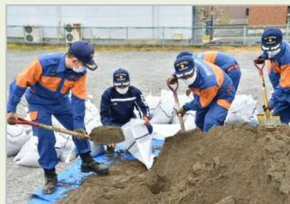
水防工法訓練の様子
