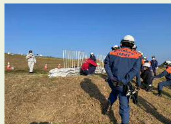
積み土のう工
