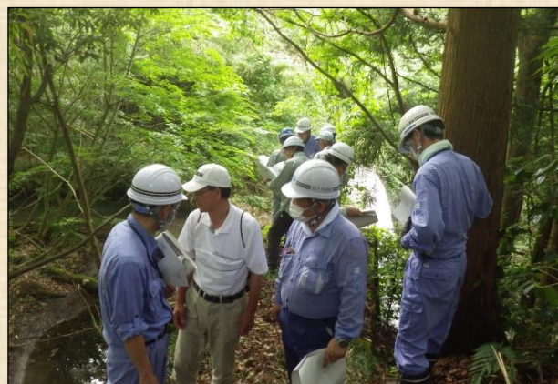
川口川砂防堰堤
