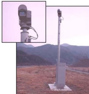
河川監視カメラ
