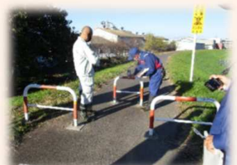
サイクリングロードの車止め視認性について検査
