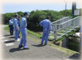
樋管周りに危険がないかを点検
