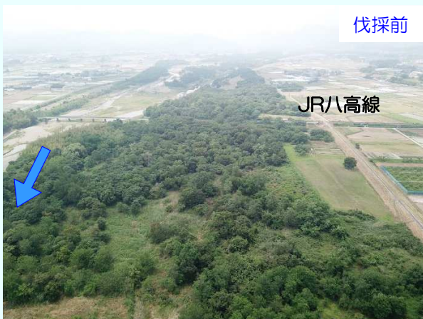
【神流川左岸 JR八高線周辺の樹木伐採状況】
