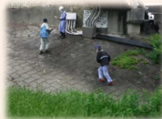
橋梁の橋台周りが適切に管理されているかを検査
