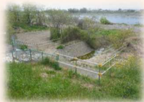
危険箇所転落防止柵を設置
