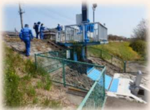
樋管周りに危険がないかを点検
