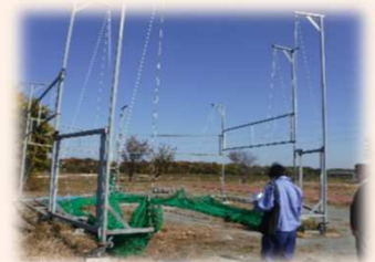
防球ネットがスムーズに撤出出来るかを検査
