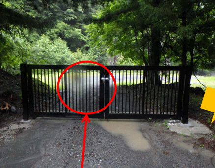
工事用地ゲートに立入禁止の表示無し
