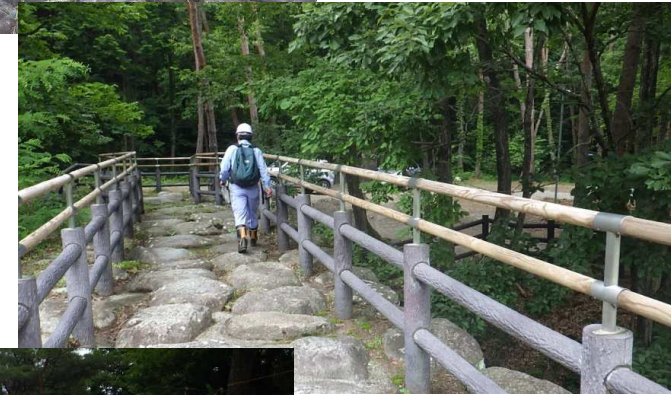
▲尾白川流域の点検状況
