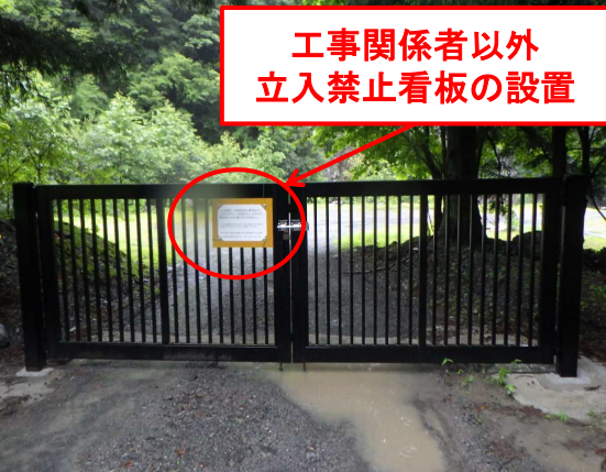
看板表示により、一般車両の進入を防ぐ。
