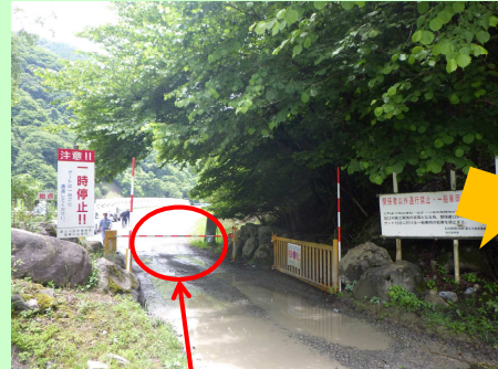
工事用道路入口ゲートに立入禁止の表示無し
