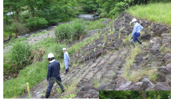
▲釜無川上流域の点検状況
