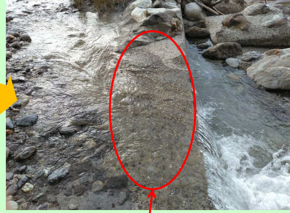
露出鉄筋の除去
