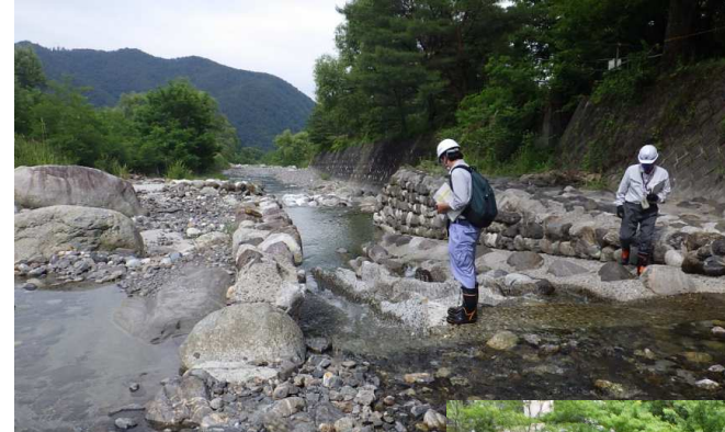
▲小武川流域の点検状況
