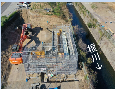
橋台フーチングの鉄筋組立・コンクリート打設が完了しました。 (令和5年12月)
