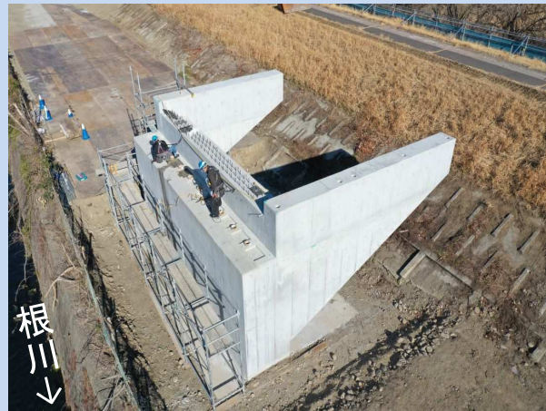
橋台を施工しています。 (令和6年1月)
