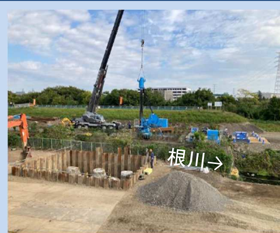
橋台底盤を床堀しています。
