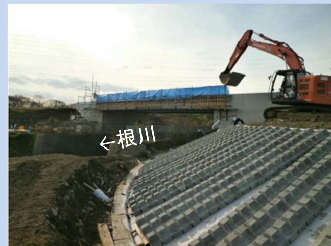
護岸を設置しています。 (令和6年2月)
