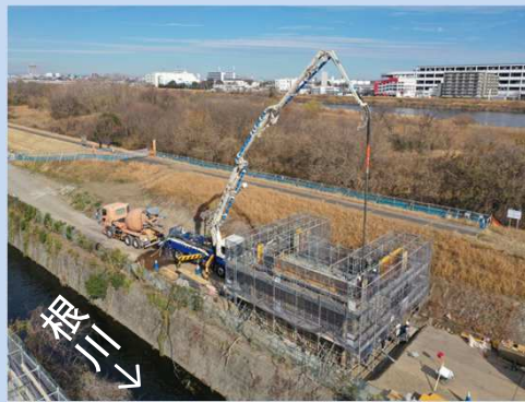
橋台フーチングの鉄筋組立・コンクリート打設が完了しました。 (令和5年12月)
