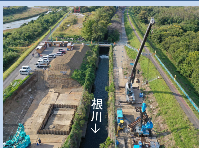
鋼矢板を打設しています。 (令和5年10月)
