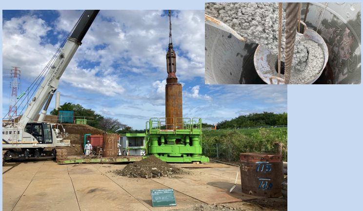
橋台の基礎杭を製作しています。 (令和5年9月)
