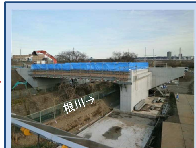
橋台を施工しています。 (令和6年2月)
