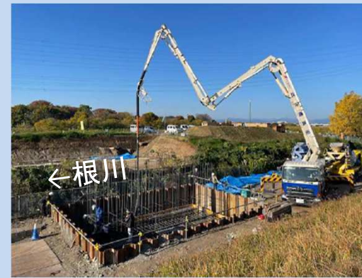
橋台フーチングの鉄筋組立・コンクリート打設を行っています。 (令和5年11月)
