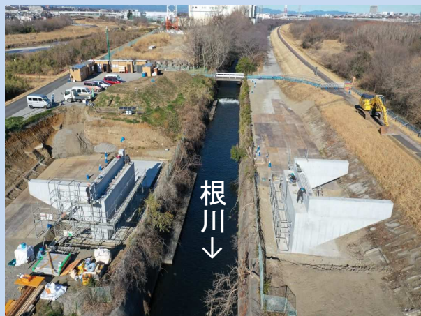
橋台を施工しています。 (令和6年1月)
