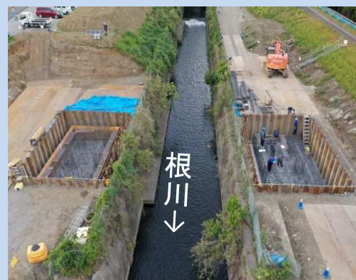
橋台フーチングの鉄筋組立・コンクリート打設を行っています。 (令和5年11月)
