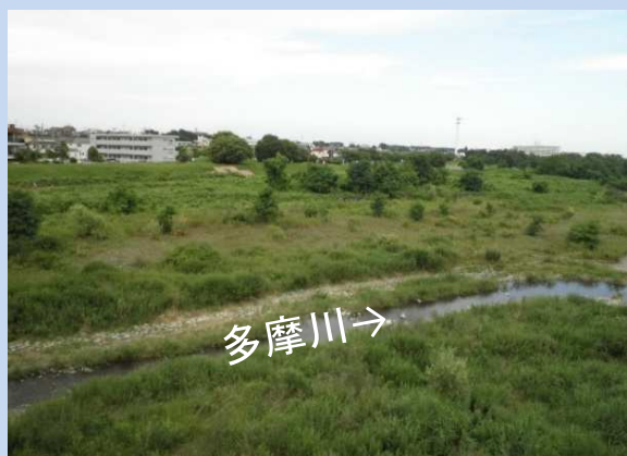
工事着手前 (令和5年6月)
