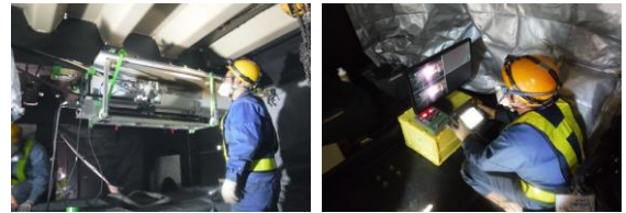
写真-1 実橋施工試験の様子
