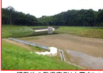
調整池の整備事例(水戸市)
