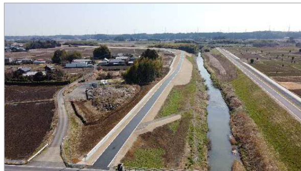
（堤防整備 茨城県）
