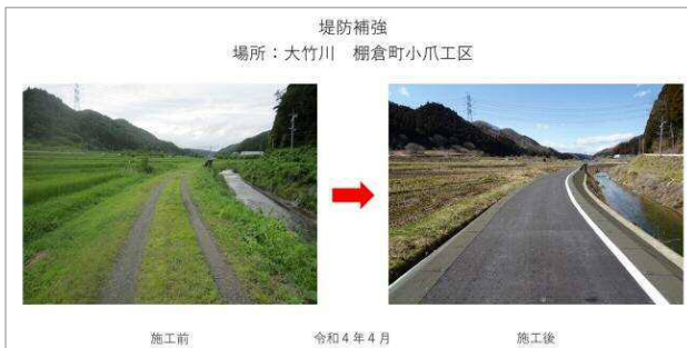
（堤防補強 福島県）
