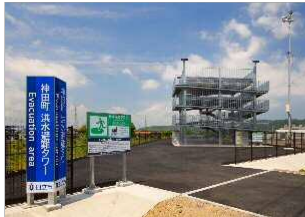
（洪水避難タワーの整備）
