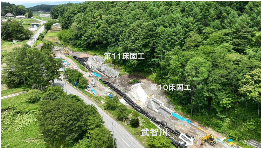
↑ 上空より施工箇所（第10床固工、流路護岸工）を望む
