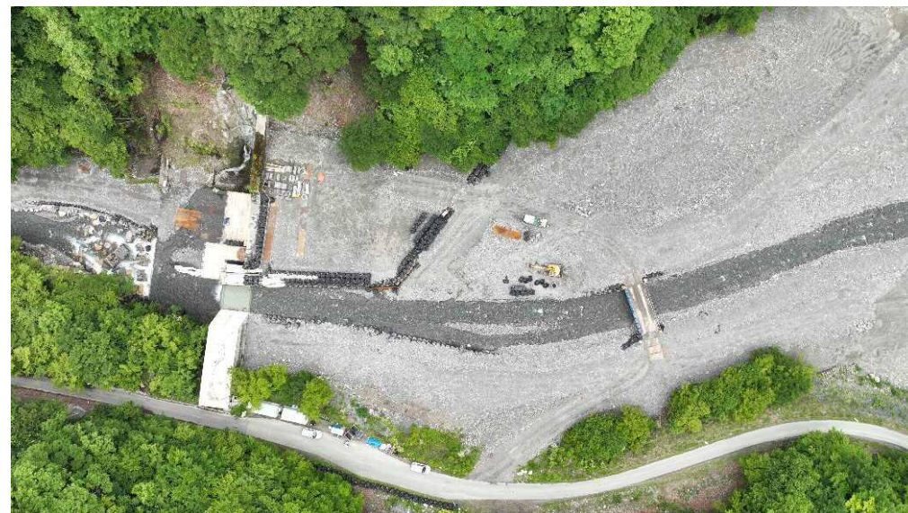
上空より本堰堤上流側を望む
