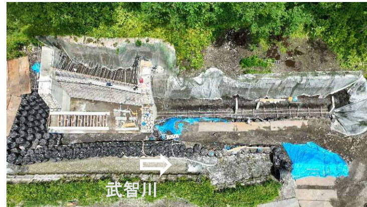
↑ 上空より施工箇所（第11床固工、流路護岸工）を望む
