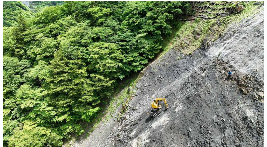
上空より施工箇所（法面整形工）を望む
