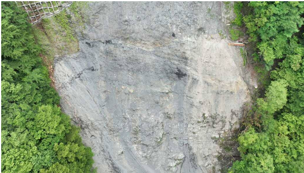
上空より施工箇所を望む
