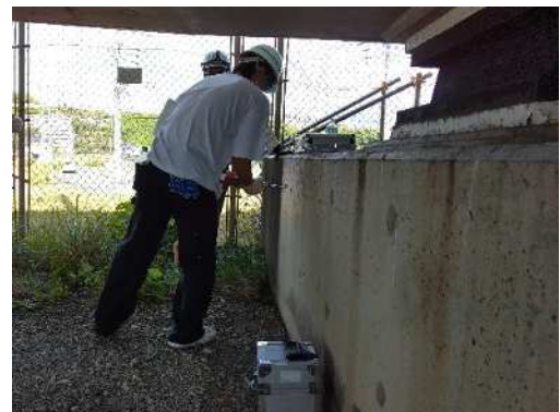
非破壊調査 (テストハンマー)
