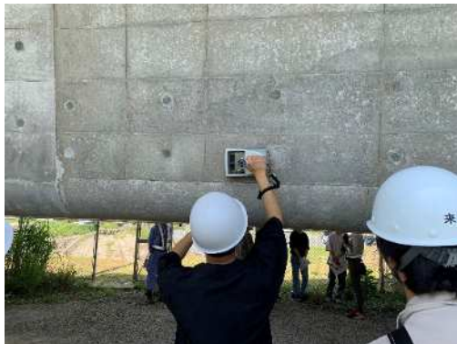
非破壊調査 (RCレーダ)
