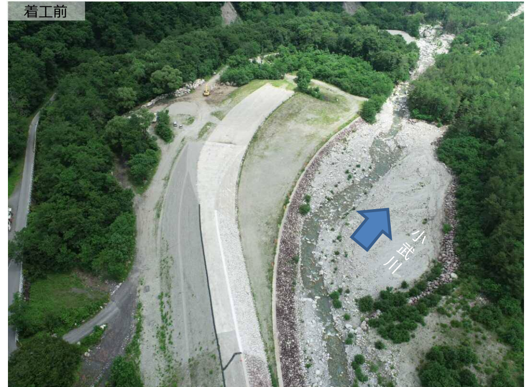
上流側より下流撮影
