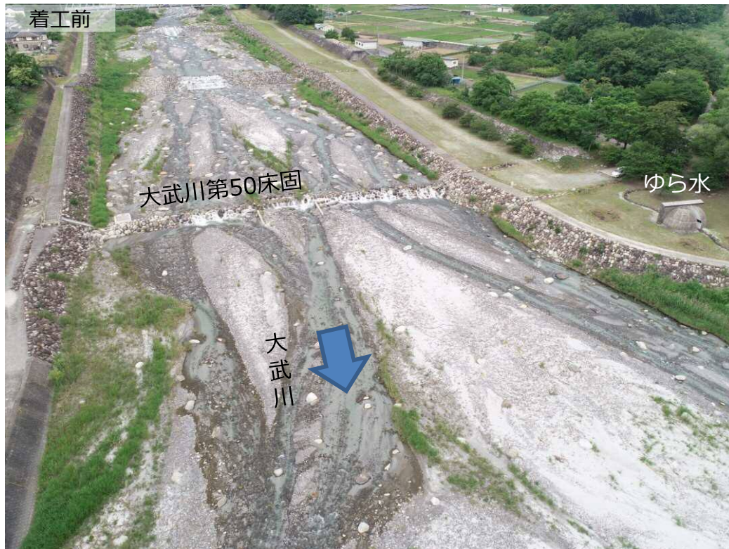
下流側より上流撮影
