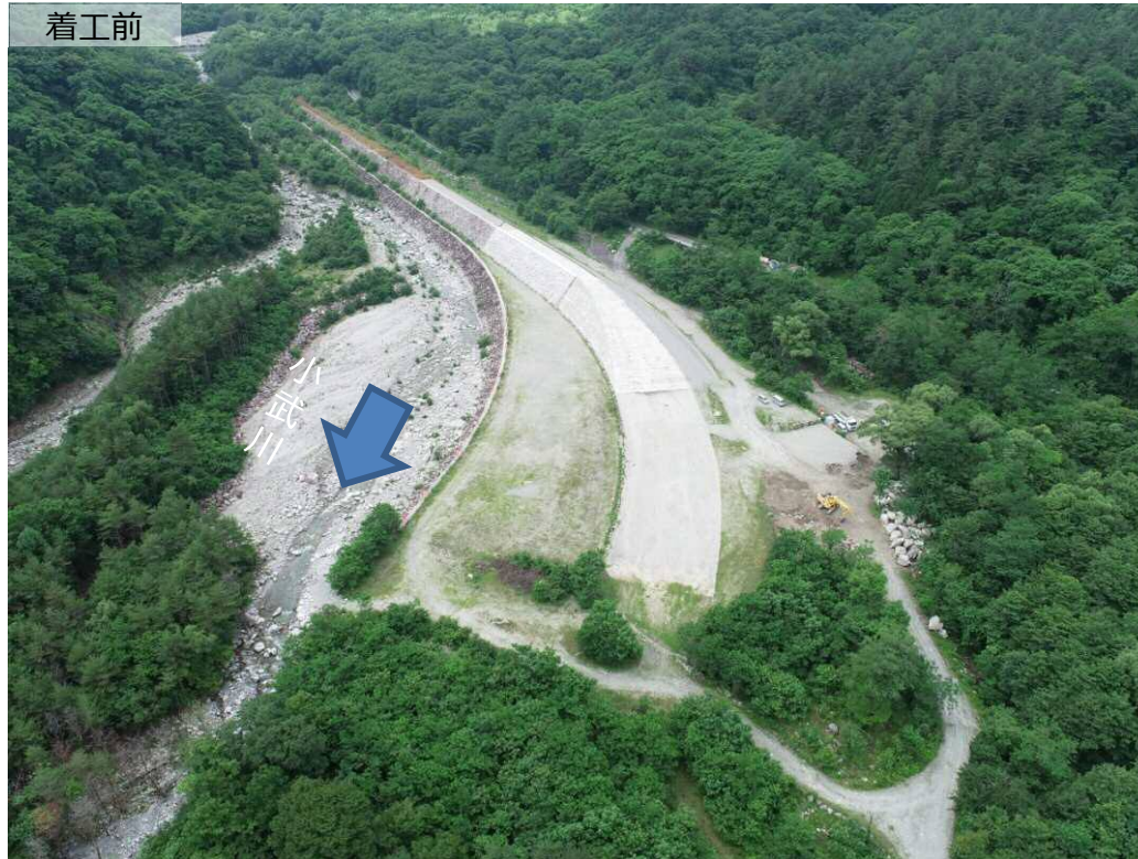
下流側より上流撮影
