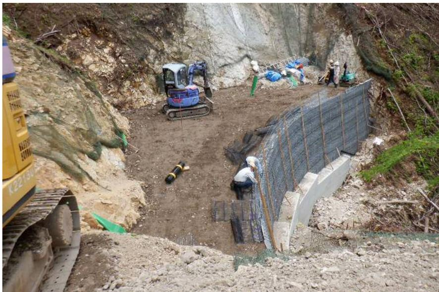
↑ 管理道路本線の谷部において、補強土壁工を施工
