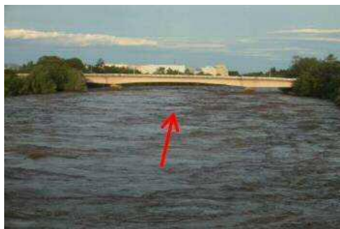
平成25年9月 利根川（玉村町上福島付近）
