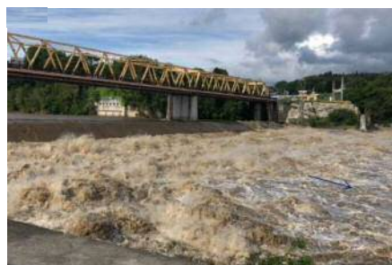
令和元年10月 利根川(渋川市半田付近)
