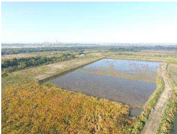
【利根川上流河川事務所 稲戸井調節池事業(調節池掘削)】
