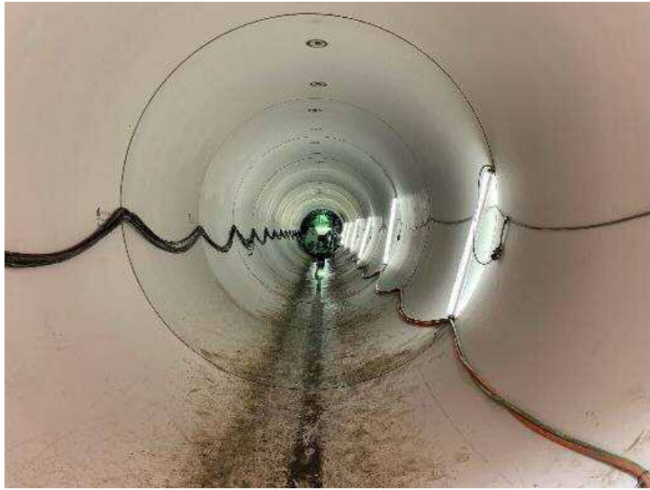
【我孫子市 柴崎雨水幹線整備】
