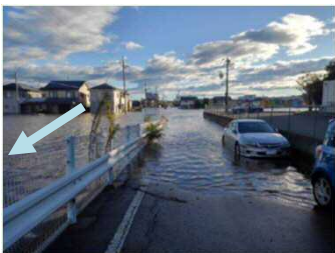
令和元年10月 被災状況
