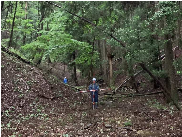
中所野下沢 (3170) 溪床状況確認
