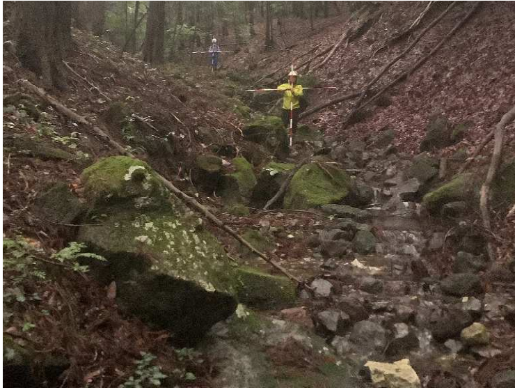
中所野中沢 (3169) 溪床状況確認
