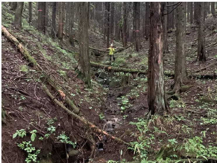
中所野上沢 (J3134) 溪床状況確認
