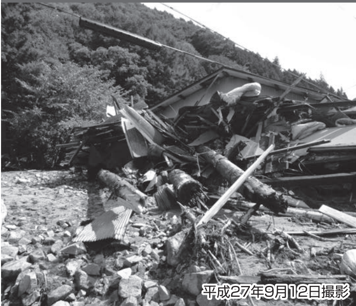
「平成27年9月関東・東北豪雨」日光市芹沢(滝向沢)
