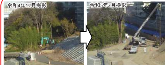
特殊堤区間整備状況(下流側)
