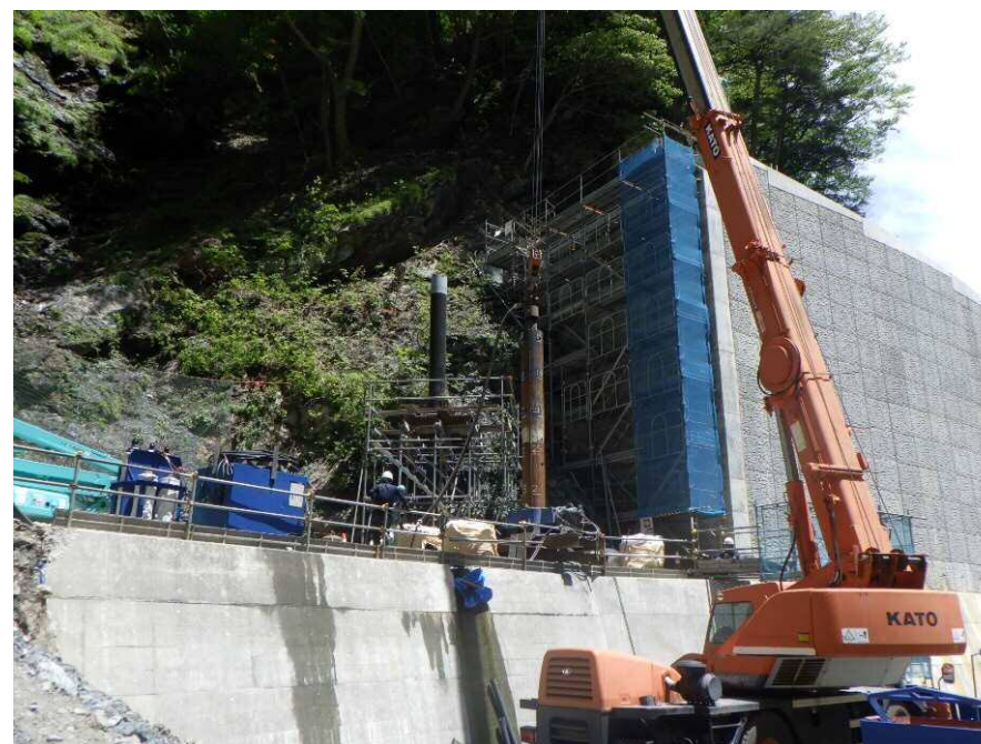
【鋼管杭施工状況】
