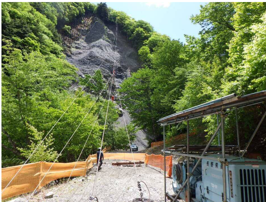
仮設工（ケーブルクレーン設置状況）
