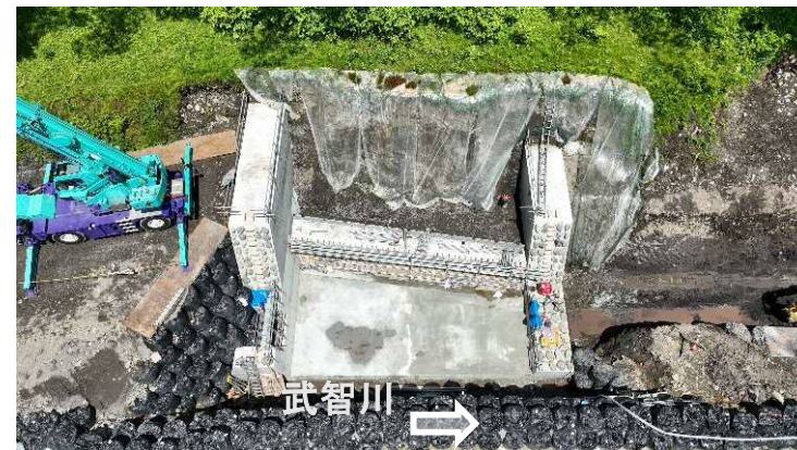
↑ 上空より施工箇所（第11床固工）を望む
