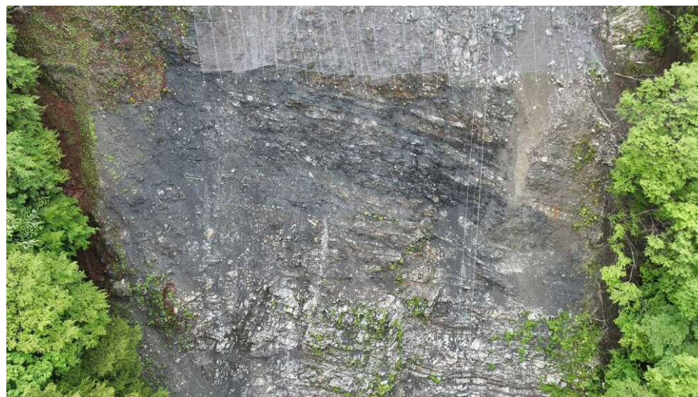
上空より施工箇所を望む
