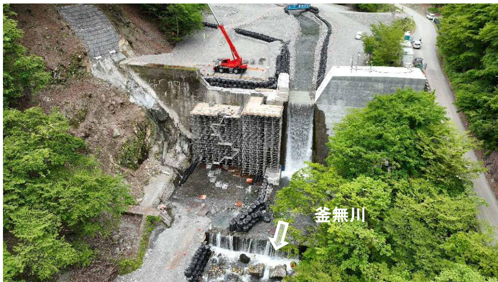
下流より本堰堤を望む
