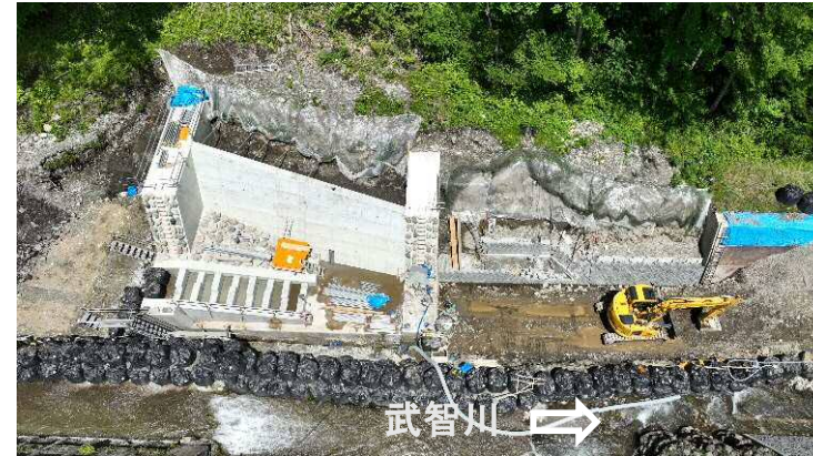
↑ 上空より施工箇所（第10床固工、流路護岸工）を望む
