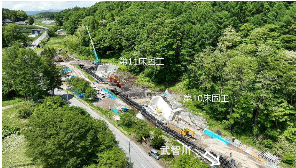
下流上空より施工箇所を望む
