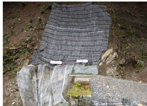
↑ 左岸より右岸を望む（法面工）
