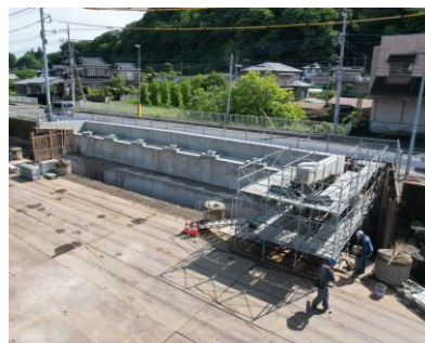
▲新規橋台(施工中)
