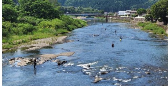
池田橋から下流架替え工事の松沼橋を望む
