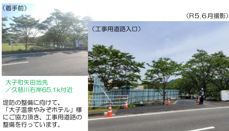
R4久慈川右岸矢田地区整備工事／株木建設(株)
