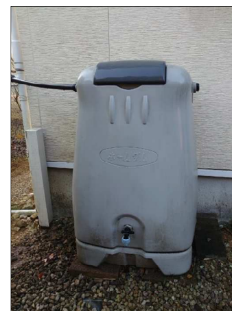
雨水貯留施設設置状況
