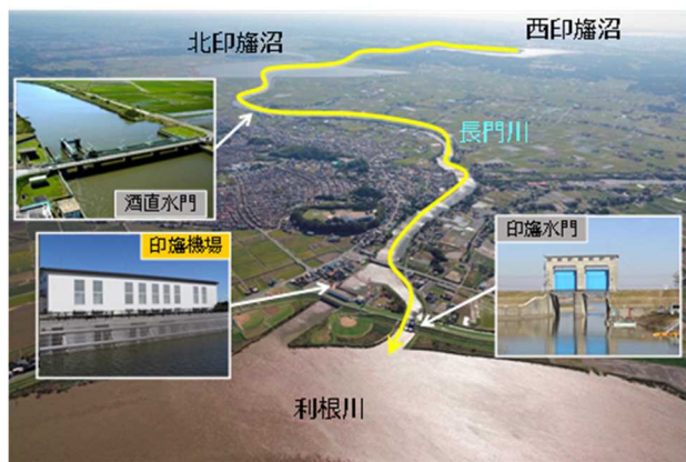
写真—1 印旛沼の利根川排水
