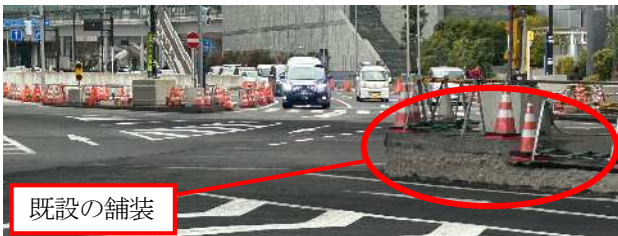
写真-3 交差点における盤下げ状況
