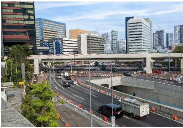
写真-1 汐留側から汐先橋交差点を望む
