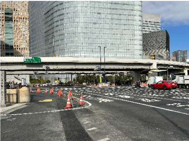
写真-2 浜離宮庭園側から汐先橋交差点を望む
