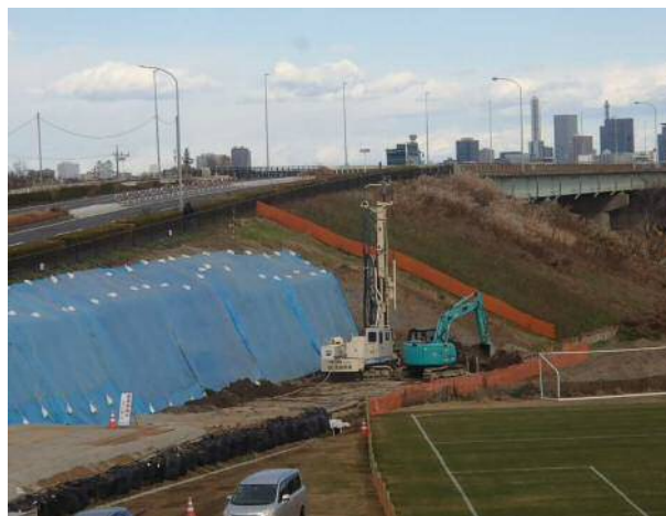
図-5 地盤改良工の施工時
