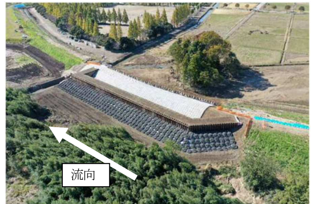
写真-2 令和元年 東日本台風 都幾川鋼矢板二重式仮締切 (高水敷側に仮締切を設置している例)
