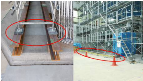
写真6 棚足場の脚の検討
