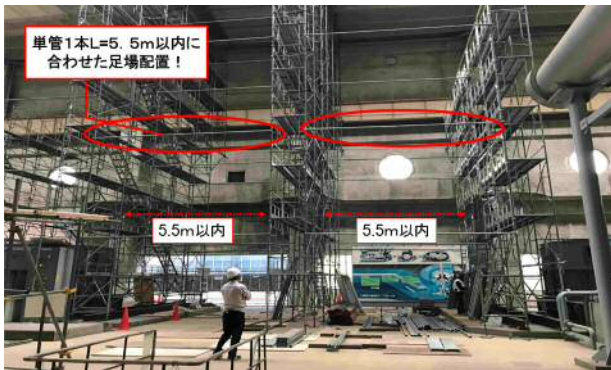
写真7 R1工事の足場
