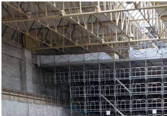
写真3 棚足場設置状況
