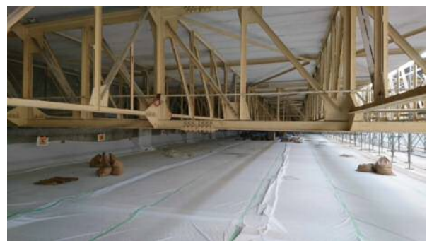
写真4 仮設足場上の状況(作業前)
