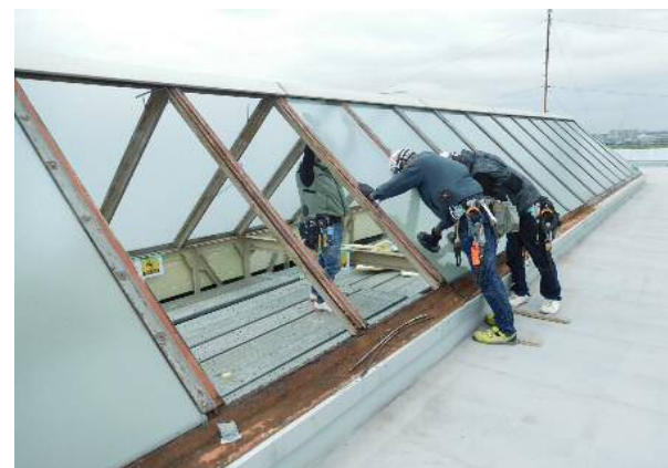
写真5 トップライトガラス撤去新設の状況
