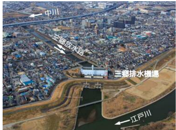
写真-1 三郷排水機場の役割
