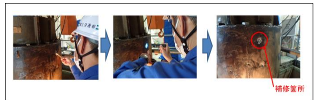
写真-11 作業の様子
