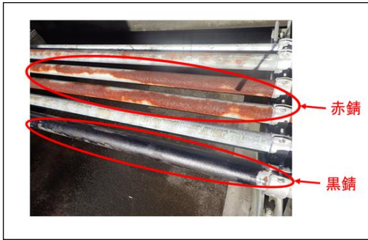
写真-7 黒錆轉換状況
