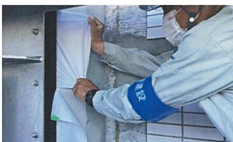
写真－５ 気密材の検査
