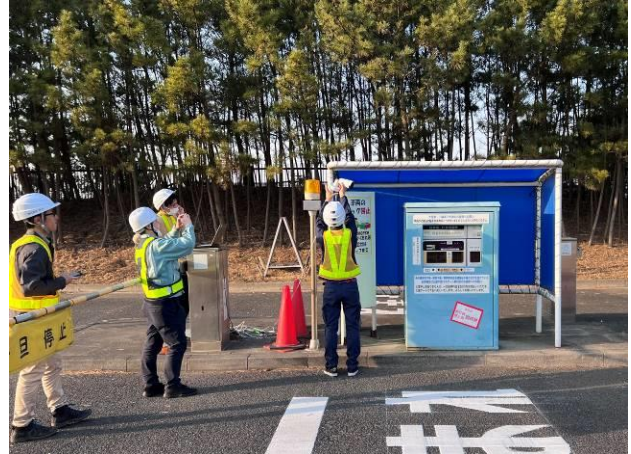
図-4 設置現場での画角調整作業
