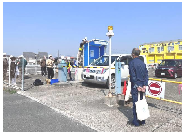
図-5 施設管理者との現場打合せ
