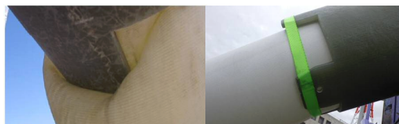
図-10 排水ホースへの食い込み状況(左)及び対策(右)
