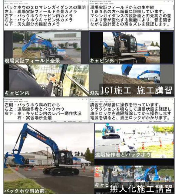
図-6 実技研修のライブ映像配信状況
