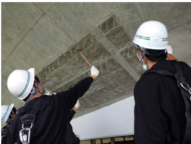
図-1 打音点検の様子
