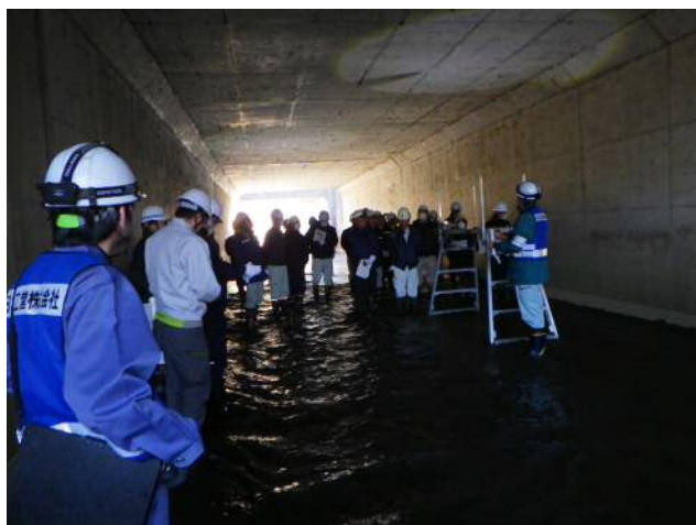
図-4 溝橋現地講習会の様子（R1年度実施）
