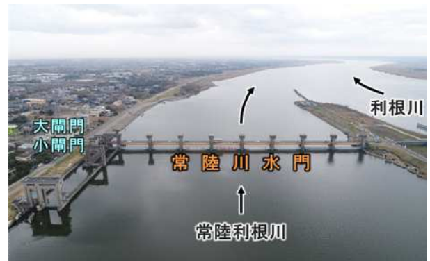
写真-1 常陸川水門・閘門の外観
