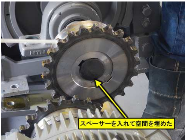
写真-4 スペーサー挿入後
