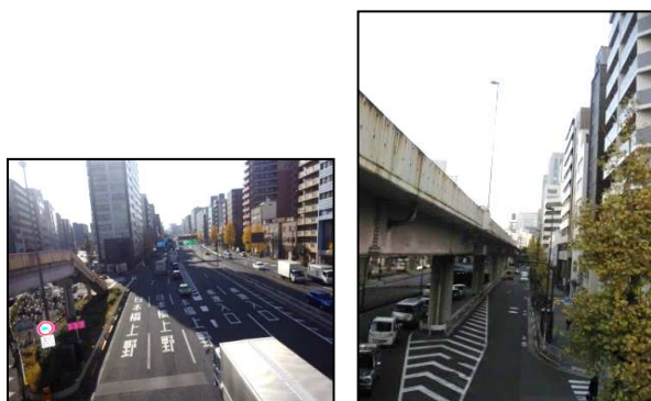
写真-3 国道4号状況写真(首都高速道路並行区間)
