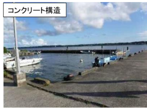
図3 下流部 許可係留施設
