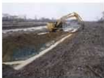
河道掘削 (石狩川水系、北海道開発局)
