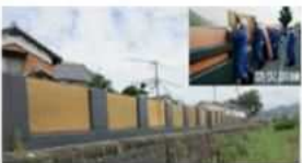
自主防災活動による畳堤設置 (楯保川水系、たつの市)
