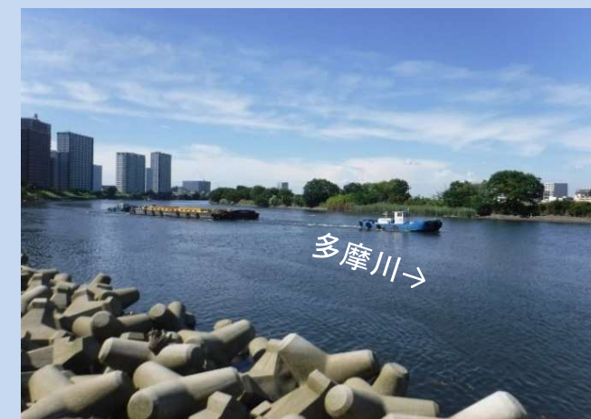
掘削した土を運搬しています。 (令和5年8月)
