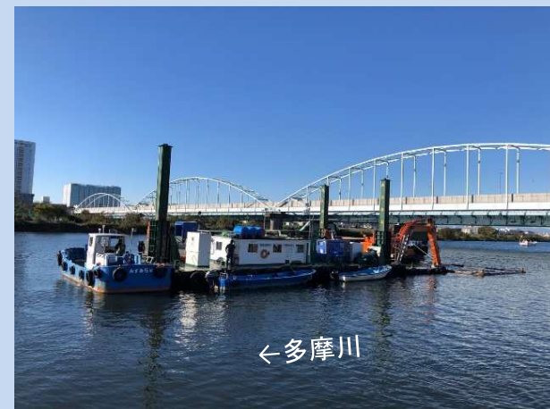
河道内を掘削しています。 (令和5年11月)
