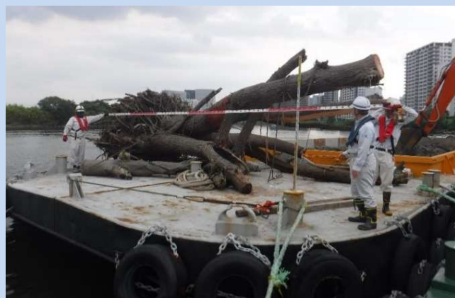
流木を撤去しました。 (令和5年9月)
