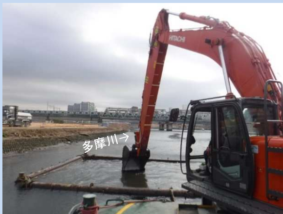
河道内を掘削しています。 (令和5年12月)
