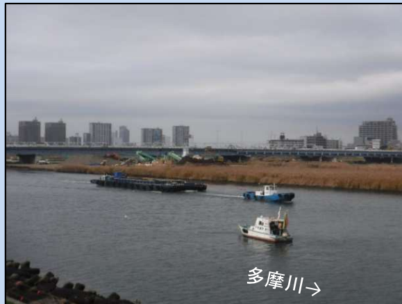
掘削した土を運搬しています。
