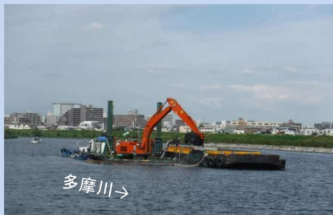
河道内を掘削しています。
