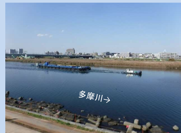
掘削した土を運搬しています。 (令和5年11月)
