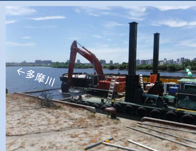
河道内を掘削しています。 (令和5年8月)
