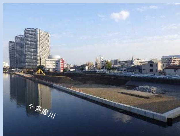
盛土を行っています。 (令和5年11月)
