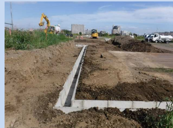
排水設備を設置しています。
