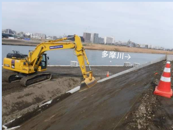
法面の整形を行っています。 (令和6年2月)
