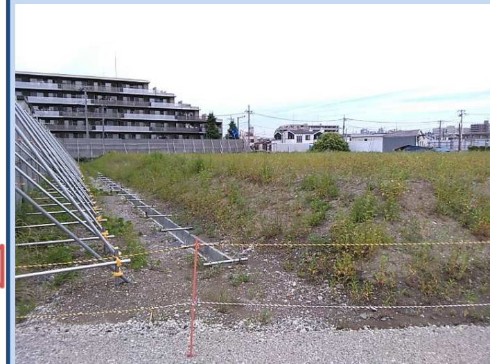
工事に入る準備をしています。 (令和5年6月)
