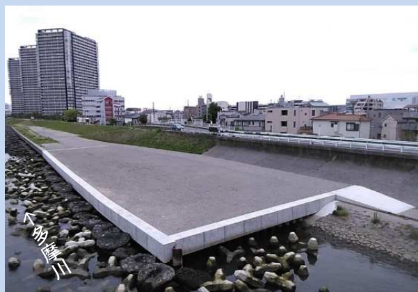
工事着手前 (令和5年7月)
