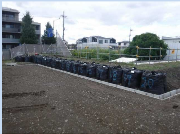
大型土のう・排水設備の設置が完了しました。排水設備の設置が完了しました。 (令和5年10月)
