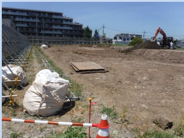
舗装・盛土撤去が完了しました。 (令和5年7月)
