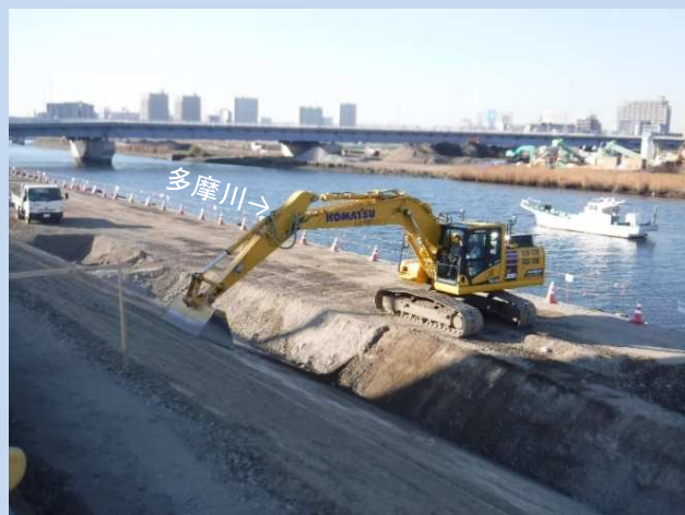
法面の整形を行っています。
