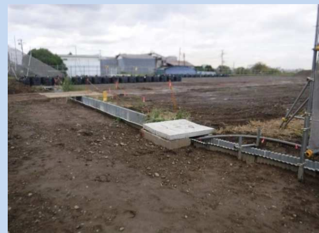
大型土のう・排水設備の設置が完了しました。排水設備の設置が完了しました。 (令和5年10月)
