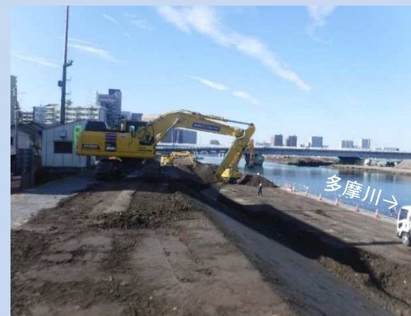
法面整形を行っています。 (令和5年12月)
