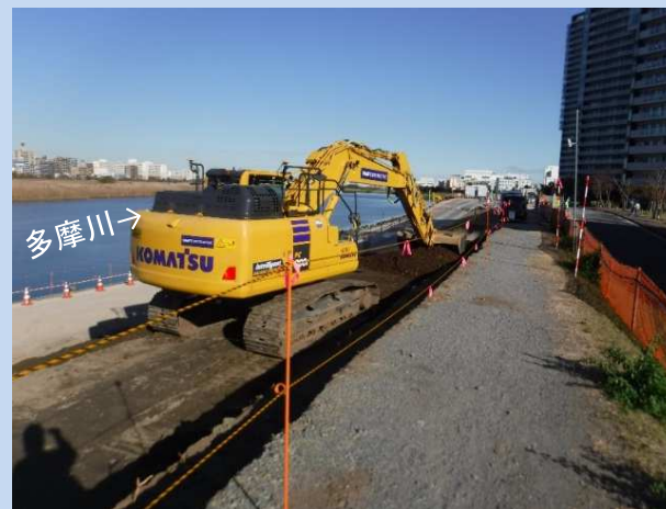
盛土を行っています。 (令和5年12月)
