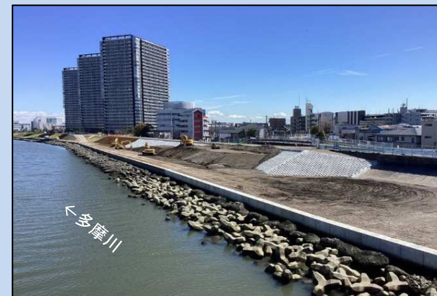
護岸を整備しています。 (令和6年3月)
