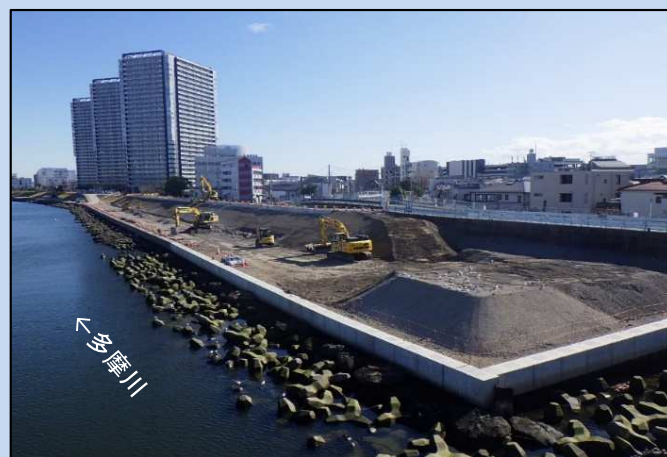
盛土を行っています。
