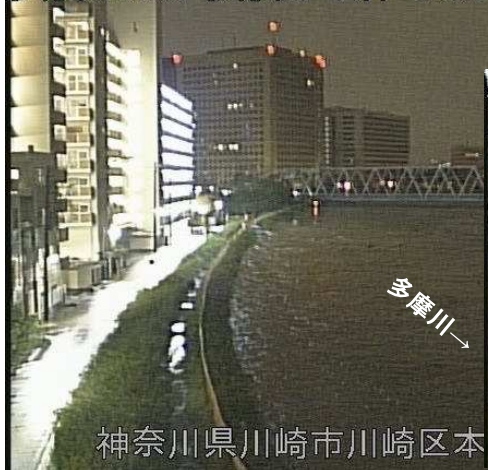
令和元年東日本台風の状況
