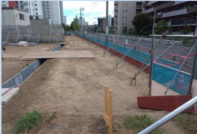
旧堤防の撤去が完了しました。 (令和5年8月)
