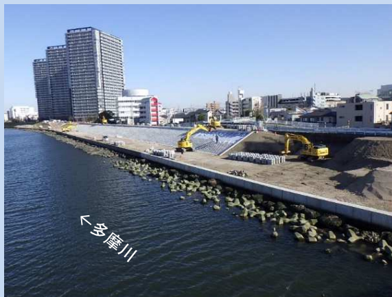
護岸を整備しています。 (令和6年2月)
