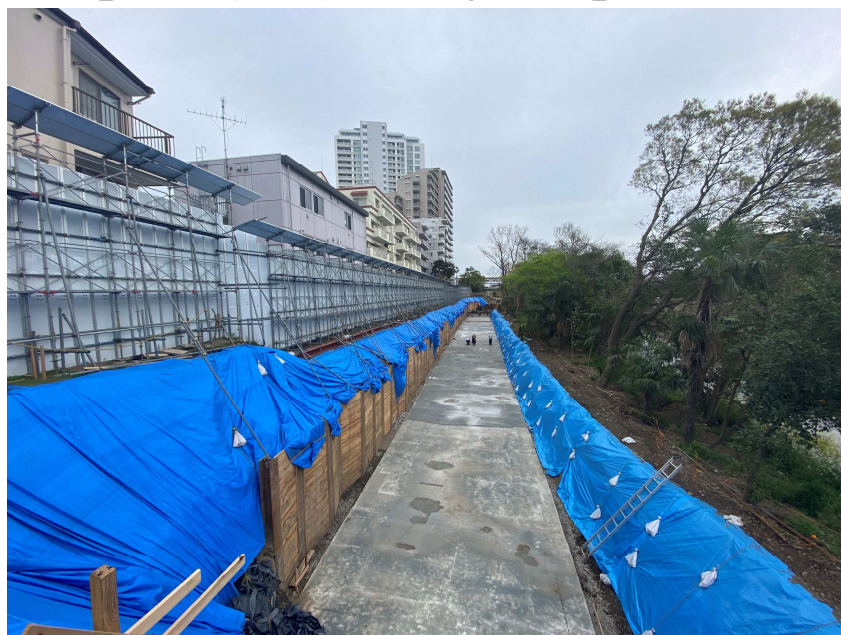
【逆T型擁壁設置工着手前】
