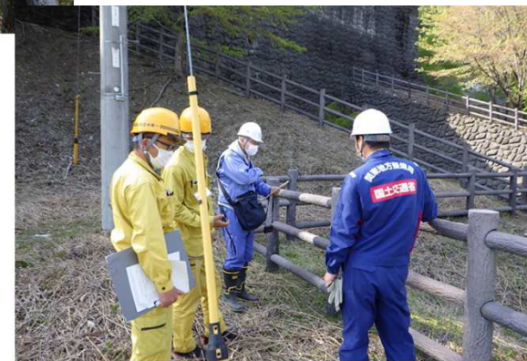
▲早川流域の点検状況
