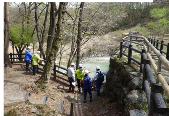
▲尾白川流域の点検状況
