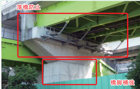
▲八潮立体高架橋
