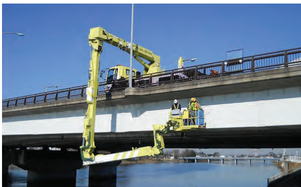
▲橋梁点検車による点検
