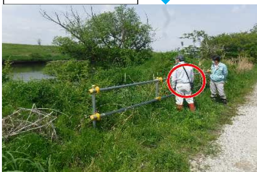
単管柵を設置
