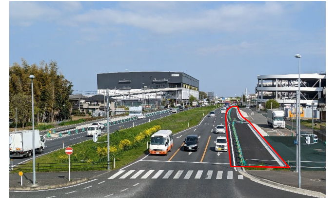
上り線の工事実施箇所
